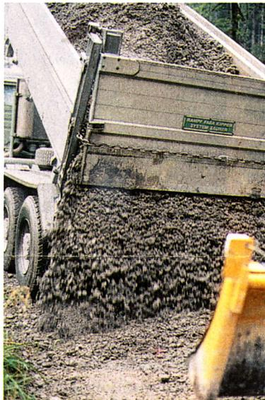
**Liefern/Einbringen:** Das aufgerissene Material wird mit ungefähr 5 cm (fertig verdichtet) zusätzlichem Verschleissmaterial abgedeckt.
