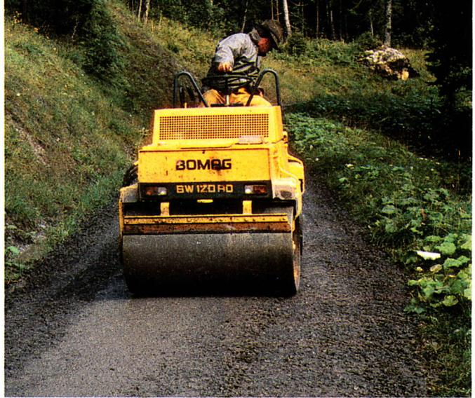
**Planieren/Verdichten:** Das vorhandene Verschleisschichtmaterial wird mit dem Grader planiert und mit Walzen verdichtet.
