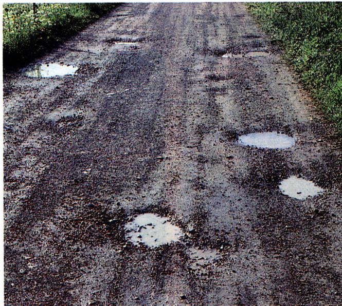
Auf flachen Strassenabschnitten kann das Wasser nicht abfliessen. Die Verschleisschicht weicht auf, und es entstehen Schlaglöcher.
