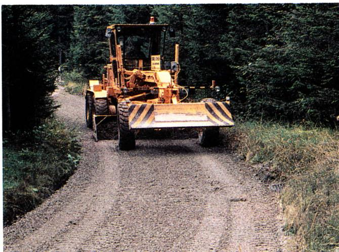
Der Längsausgleich erfolgt in mehreren Durchgängen über eine längere Strecke.
