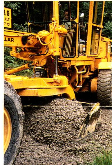
**Verteilen:** Mit dem bombierten Graderschild wird das Verschleisschichtmaterial gleichmässig über die Strassenoberfläche verteilt.
