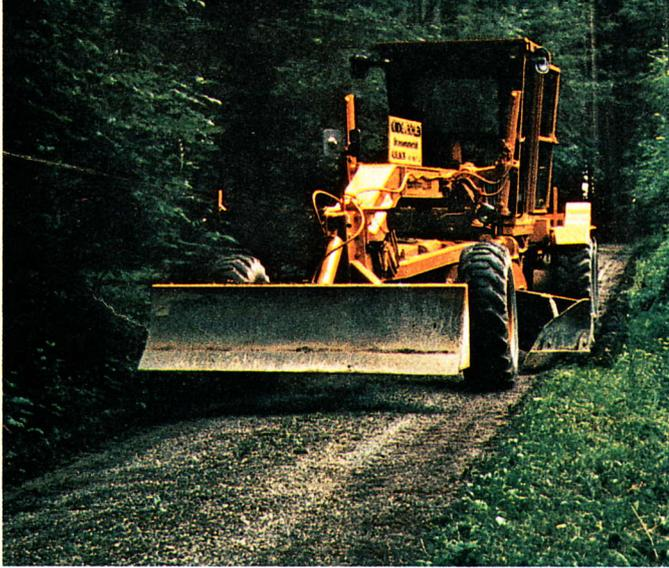
**Abbranden:** Mit einem fahrbaren Grader werden die Strassenränder abgerandet.
