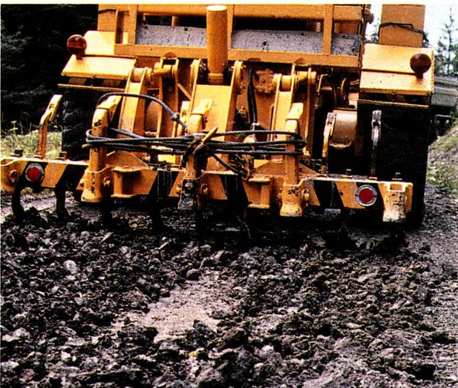
**Aufreissen:** Das bestehende Verschleisschichtmaterial wird mit dem Grader aufgerissen.
