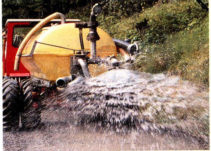
**Bewässern/Einschlämmen:** Falls das vorhandene und/oder das zugeliessene Verschleisschichtmaterial zu trocken ist, muss das Material, zur Erreichung des für die Verdichtung optimalen Wassergehaltes, bewässert und eingeschlämmt werden.
